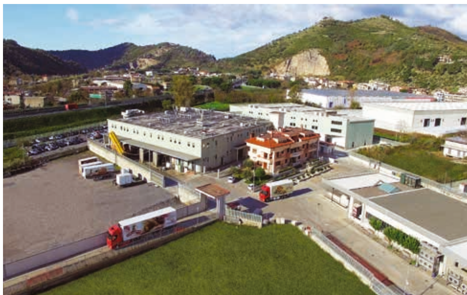
Lo stabilimento di San Giorgio Spa a Castel San Giorgio (Sa)
